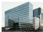
7 Dronning Eufemiasgate 8 (Braathen eiendom) Komfortkjøling Rekkverk Belysning Glassfasader Gulvoverflate Sanitær Brannrelange- skap Innvendig kledning Innder
